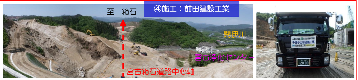
小山田トンネル箱石側坑口部の切土工事を行っています。施工開始前のトンネル直上から箱石側を望んだ景色です。当工事のダンプトラックは、このゼッケンをつけて運搬しています。
