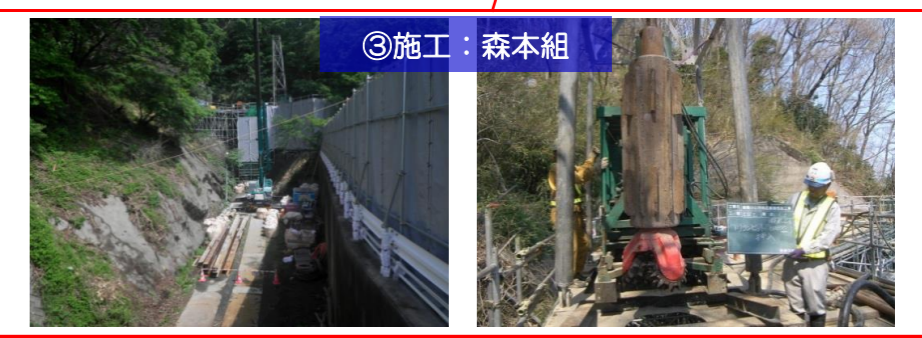
ボックスカルバートを設置する範囲の掘削用土留めを設置しています。土留めはビットと呼ばれるドリル(写真右)を大型ボーリングマシンにセットし、削孔した後、H鋼を建て込みます。
