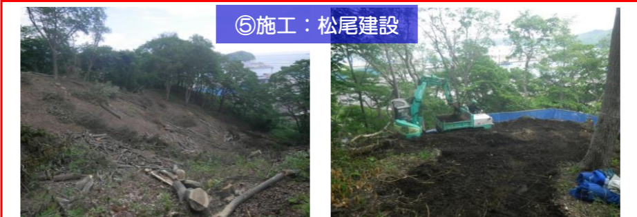
道路が出来る範囲の伐採作業を進めています。文化財調査が行われています。(磯鶏石崎遺跡B)
