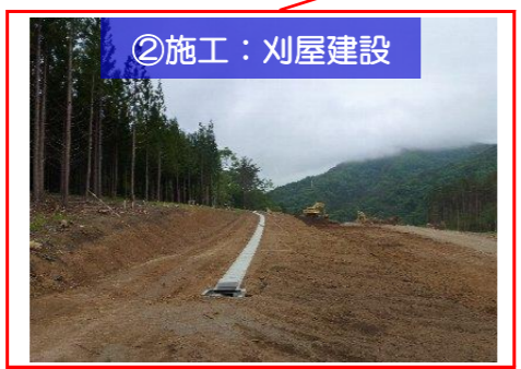
土工事と水路工事を進めています。
