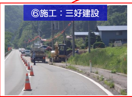
国道106号(川井第1地割)の交通規制が始まりました。
